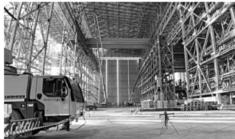
ГРУЗОПОДЪЕМНОСТЬ каждого мостового крана составила 300 тонн
