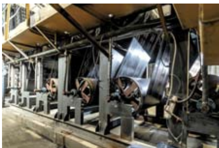
Фото: «Мягкая кровля»
